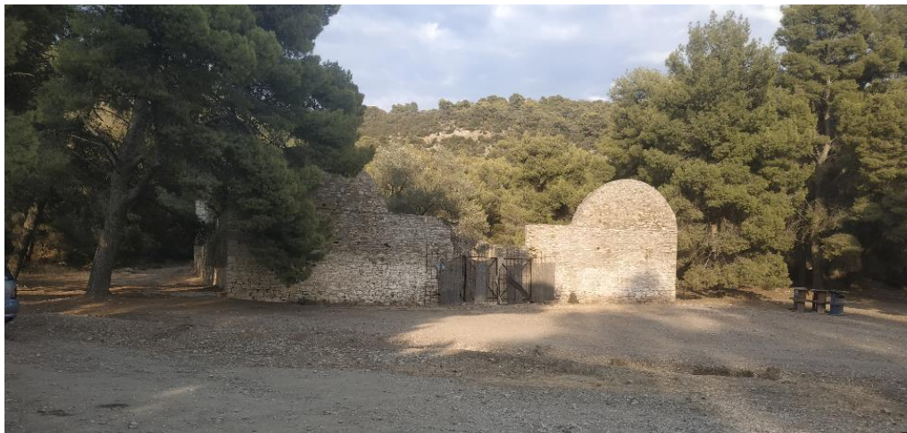
Εικ.20: Ο χώρος των αποθηκών του Ναύσταθμου χρησιμεύει ως χώρος κατασκήνωσης τους θερινούς μήνες
