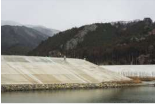
Εικόνα Α 8. Ένα θαλάσσιο τείχος (κυματοθραύστης) στο Ogatsu, στο Νομό Miyagi, για να προστατεύσει την περιοχή από μελλοντικό tsunami.
